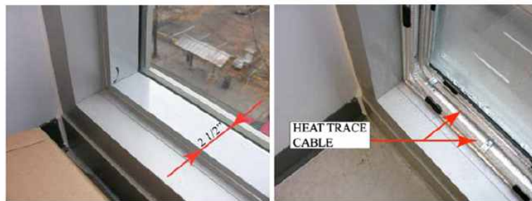
[그림 25] electrical heat tracing system 예
