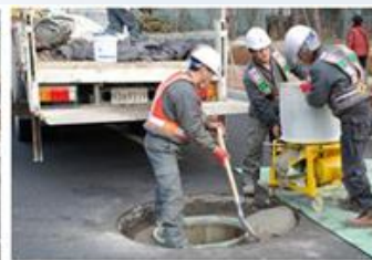
3. 초속경형 고강도 콘크리트 타설
