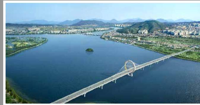
▲ 초고강도, 고기능, 고품질의 슈퍼 콘크리트 개발
