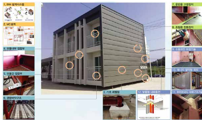
[ 모듈러 공동주택 Mock-up 구축 및 12대 실증기술(충북 K사 진천공장, 2014.08) ]
