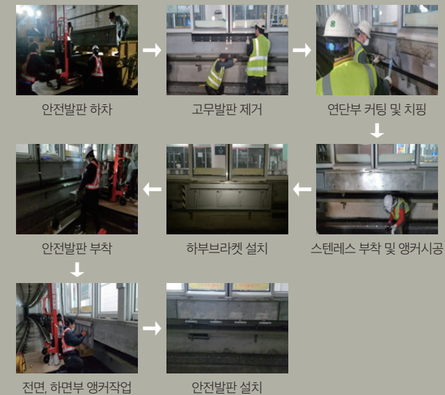
그림 1 승강장 안전발판 시공순서
