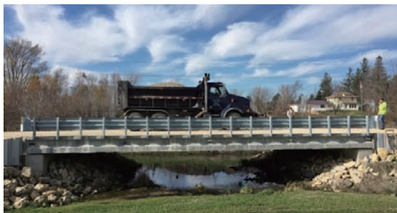
미국 아이오와주 뷰키너 카운티의 Hawkeye UHPC Bridge
