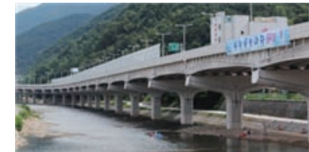
신천좌안대로 건설공사 신천좌안교
