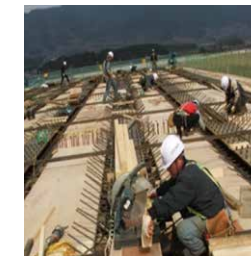
■ 재래식 슬래브 시공
