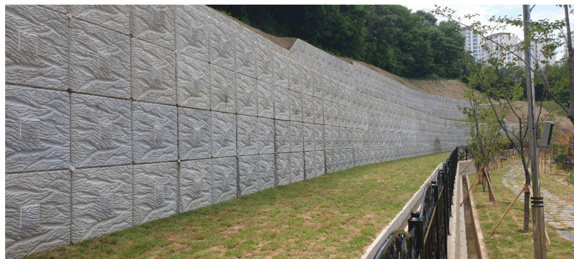
원지반 부착방식의 절토부 옹벽 시공전경
