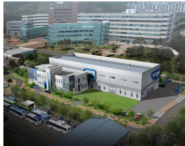
소단면 터널식 공동구 실대형 성능검증 시설 전경
