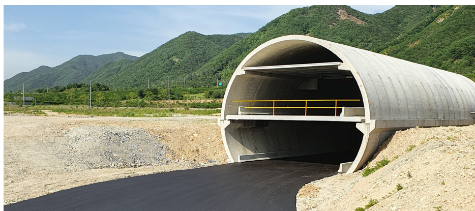
복층터널 구축 테스트베드 시범현장
