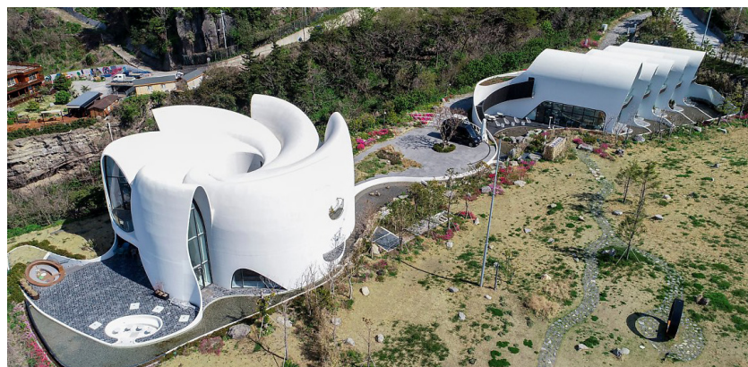
세계 최초의 UHPC(초고성능콘크리트) 건물인 울릉도 힐링스테이 리조트(2017)
