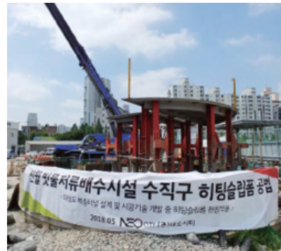
수직구 급속 시공 기술
