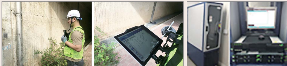
실제 현장 사용 사진
