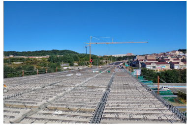
하부콘크리트 양생 후 상부슬래브 타설 및 양생
