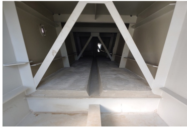
강거더 압축플랜지의 거푸집 설치, 하부콘크리트 타설 및 양생
