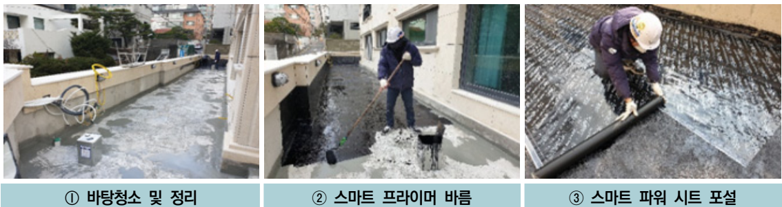
〈표 1〉 SMART POWER SYSTEM의 시공순서
