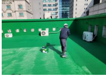
⑤ WaNaB 도막 상도(탑코팅재) 전면 도포 및 마감
