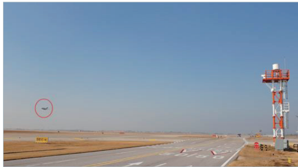
인천국제공항에 설치된 고정형 이물질 자동탐지 시스템
