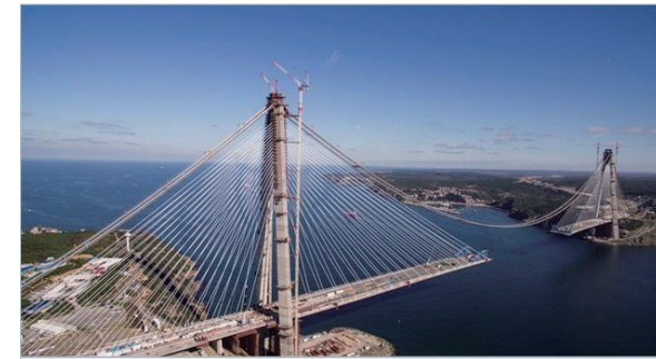
터키 보스포루스 제3대교 건설 모습(2015)
