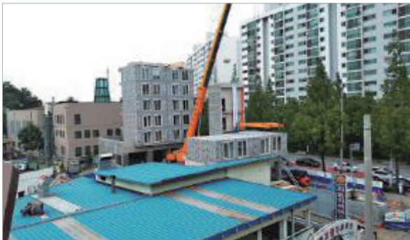
서울 강서구 가양동 모듈러 행복주택 조립 현장
