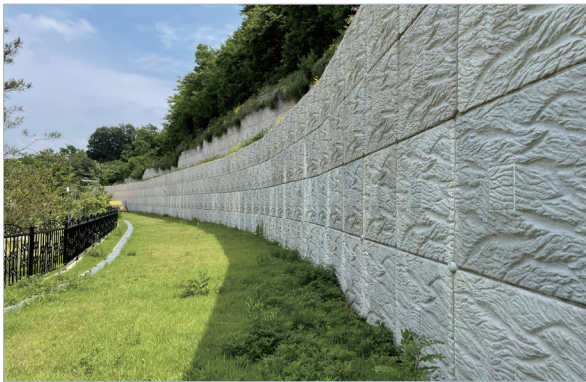
원지반 부착방식의 절토부 옹벽 시공전경
