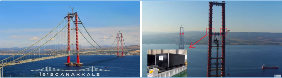
2022년 터키 1915 차나칼레 대교에 설치된 AMD(이동질량:30ton, 설치높이:225m)
