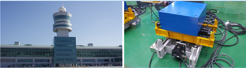
2015년 인천국제공항 제2계류장관제탑 AMD(이동질량 9ton,설치높이 65m)
