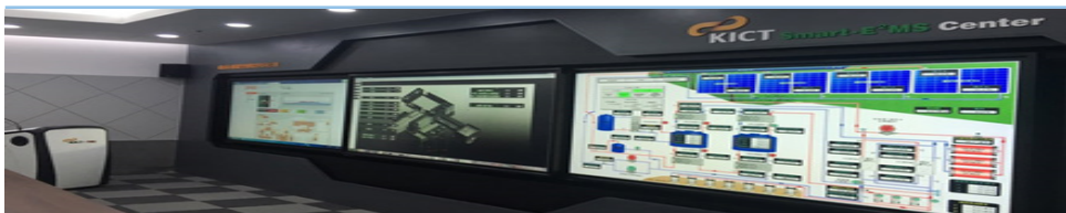
2017년부터 운영을 개시한 한국건설기술연구원 화성청사 BEMS 관제시스템. 전력소비, 냉난방시스템, 신재생에너지설비 등 에너지 사용량 모니터링 및 최적 운영관리를 통해 20% 수준의 에너지 절감실적 달성
