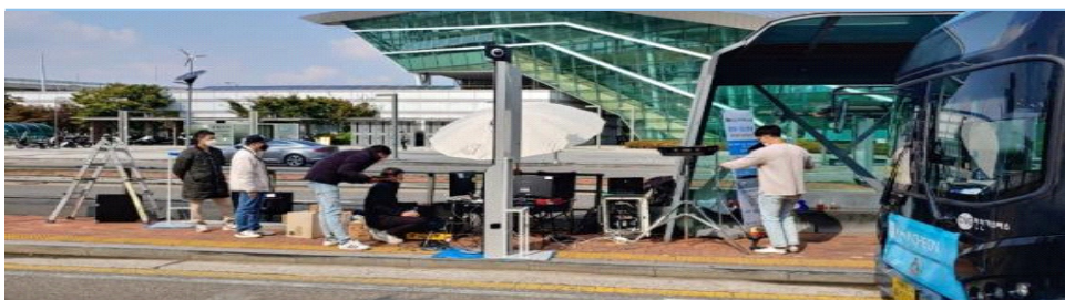
청라역 정류장 1개소에 설치된 정류장 지원시스템. 차량 진입부터 11단계 시나리오를 통해 정차위치, 돌발상황, 대기승객 혼잡도 승하차 상황 종합 검지성능 시험 진행. 검지 정확도 95.8% 이상 달성
