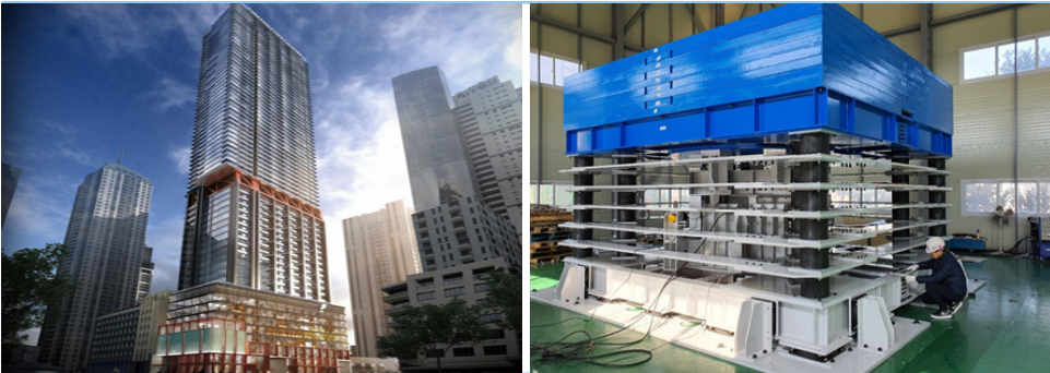
2019년 호주 시드니 Greenland Centre에 설치된 LRB TMD(이동질량 180ton,설치높이 235m)
