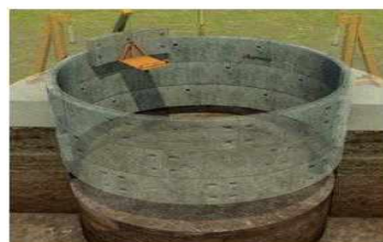
[그림 5-22] Humes segmental shafts 공법(Humes(호주), 2015)
