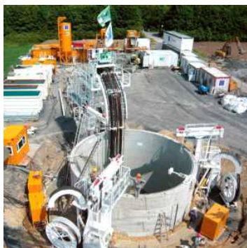
[그림 5-24] VSM(Vertical Shaft Sinking Machine)(독일)
