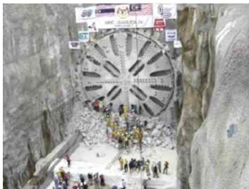
(a) 도로 굴착 현황
