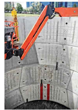
(c) 세그먼트 조립 전경
