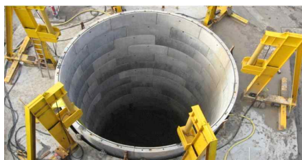
[그림 5-22] Humes segmental shafts 공법(Humes(호주), 2015)
