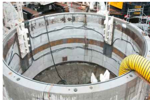
[그림 5-24] VSM(Vertical Shaft Sinking Machine)(독일)
