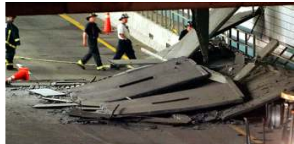
(b) 콘크리트 슬래브 낙하로 인한 사고 사례 (Boston BigDig Tunnel)
