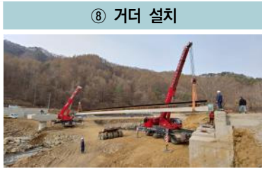
크레인을 활용한 거더 설치
