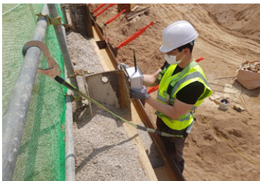
① MEMS무선센서 설치
