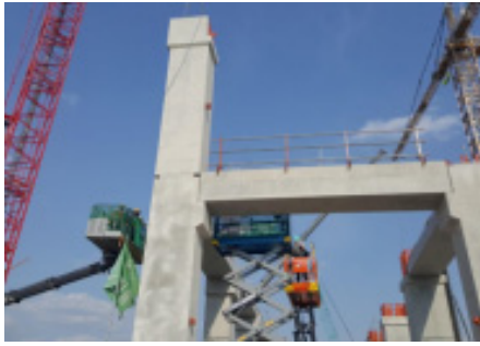
⑦ 상부층 기둥 인양 및 조립
