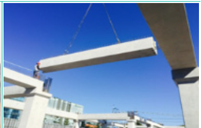
③ 거더 인양 및 조립
