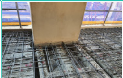
⑥ 보 및 슬래브 철근 배근
