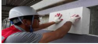
(3) 화재확산 방지재료의 벽체 밀실 시공
