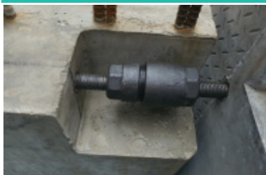
④ 거더 기계적 이음장치 체결
