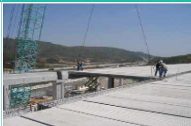
⑤ 슬래브 인양 및 조립
