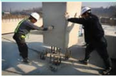
① 기둥 인양 및 조립
