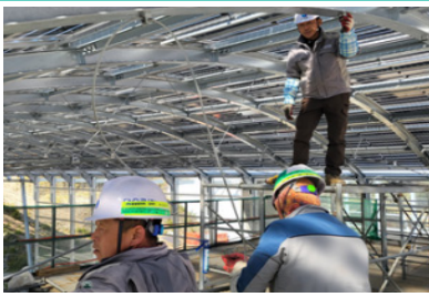
4. 컨트롤 로프 설치
