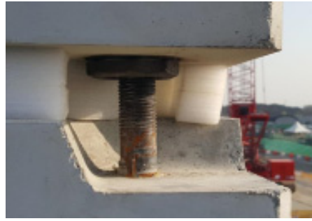
⑧ 기둥 기계적 이음장치 체결(기둥+기둥)
