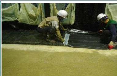
④ 이음부 시공
