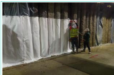
② 보호재 시공
