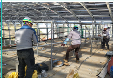
3. 타이 케이블 설치
