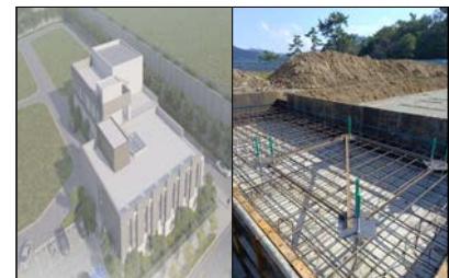
< 테스트베드 조감도 및 현장 >
