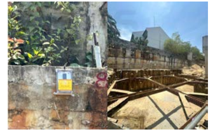
<베트남 건설현장 실증>
